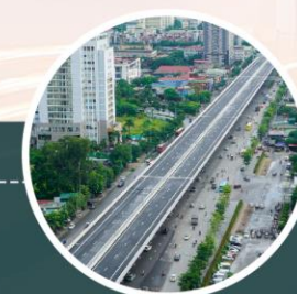
Cơ bản hoàn thành đường Vành đai 3 (Hà Nội)
