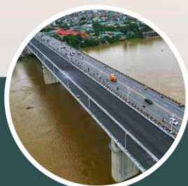
Cầu Vĩnh Tuy 1 hoàn thành (Hà Nội)
