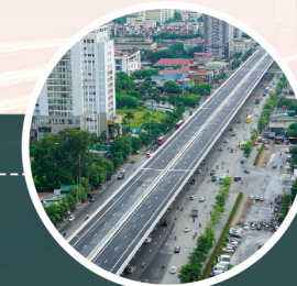
Cơ bản hoàn thành đường vành đai 3 (Hà Nội)
