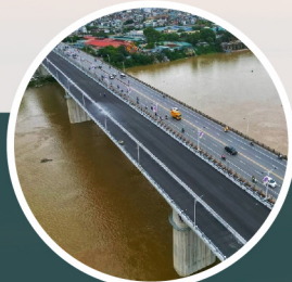
Cầu Vĩnh Tuy 1 hoàn thành (Hà Nội)
